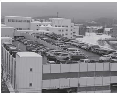
病院立体駐車場の屋上階
